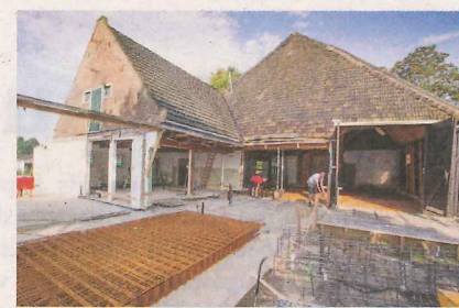
'Bouwbedrijf Appelman, totaalinstallateur Wilms Den Helder bv en constructiebedrijf Harder zijn druk bezig om de boerderij compleet naar onze wensen te maken.'
